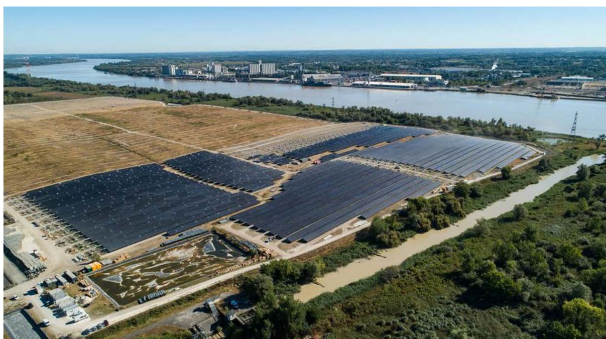
Chantier d'installation de 140 000 panneaux photovoltaïques sur l'ancienne décharge de Labarde à Bordeaux
