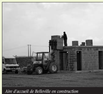
Aire d'accueil de Belleville en construction
