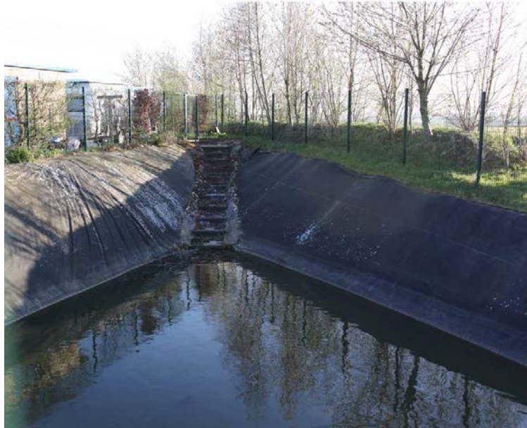
L'un des deux bassins de rétention d'eau situés à l'entrée de l'aire de Bolbec
