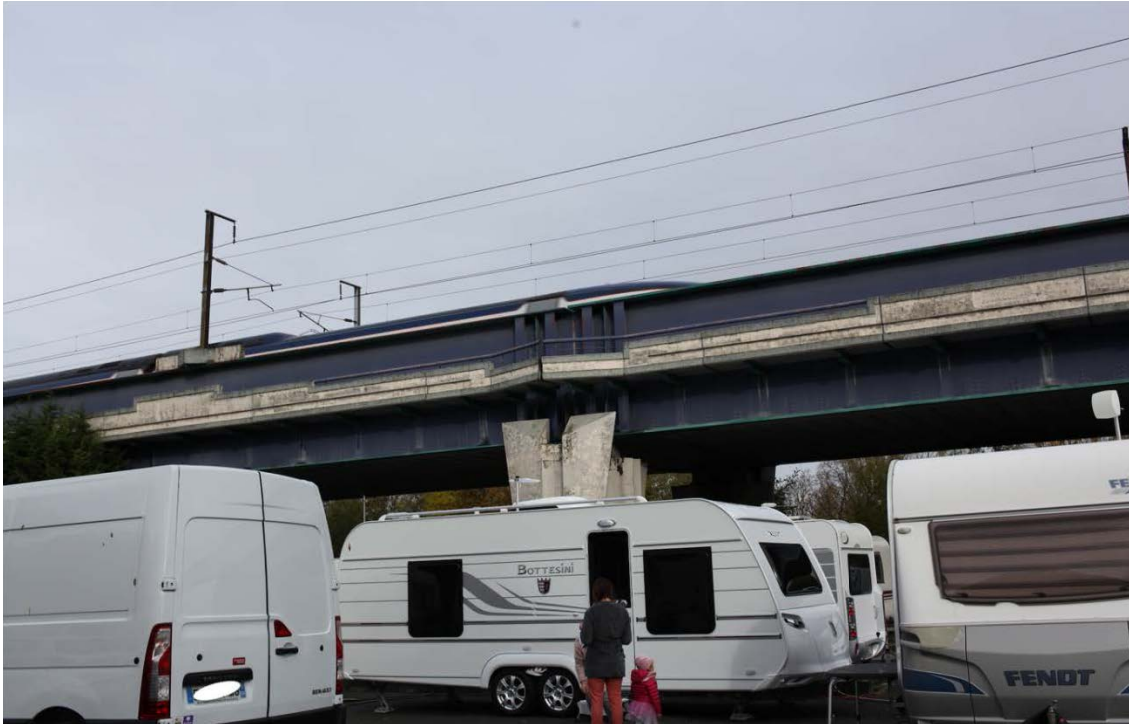
Passage d'un train sur le viaduc de la LGV Paris-Bruxelles surplombant l'aire de Saint-André-Lez-Lille
