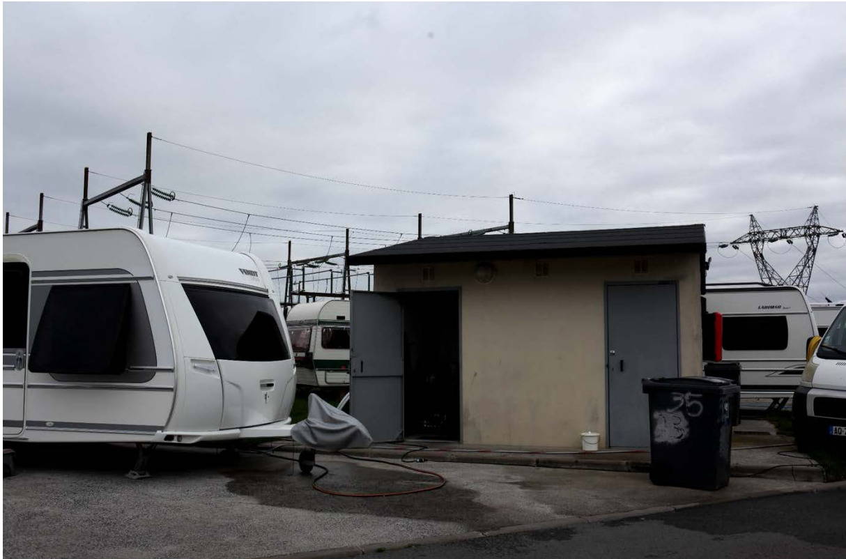
Vue sur le transformateur électrique depuis un emplacement de l'aire de La Chapelle-d'Armentières
