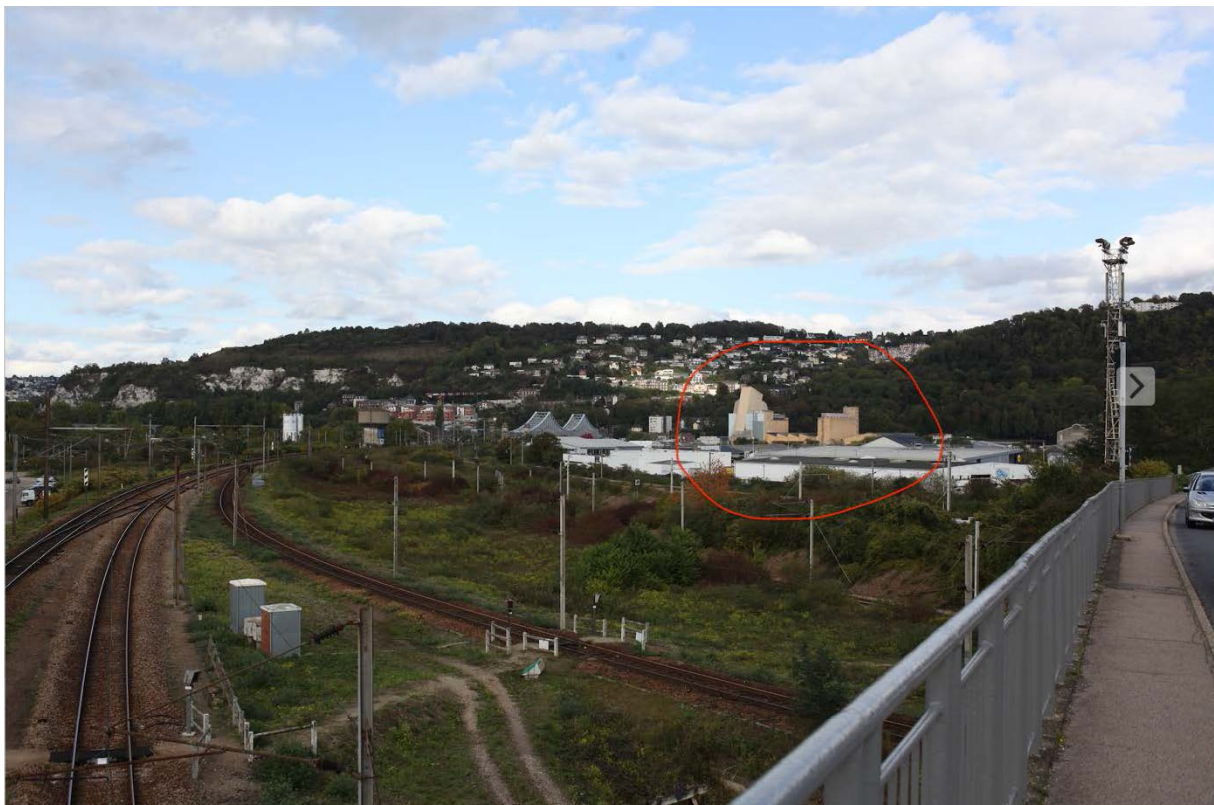
Vue distanciée de l'aire d'accueil depuis le pont qui passe sur les voies ferrées, avec comme repère l'usine
