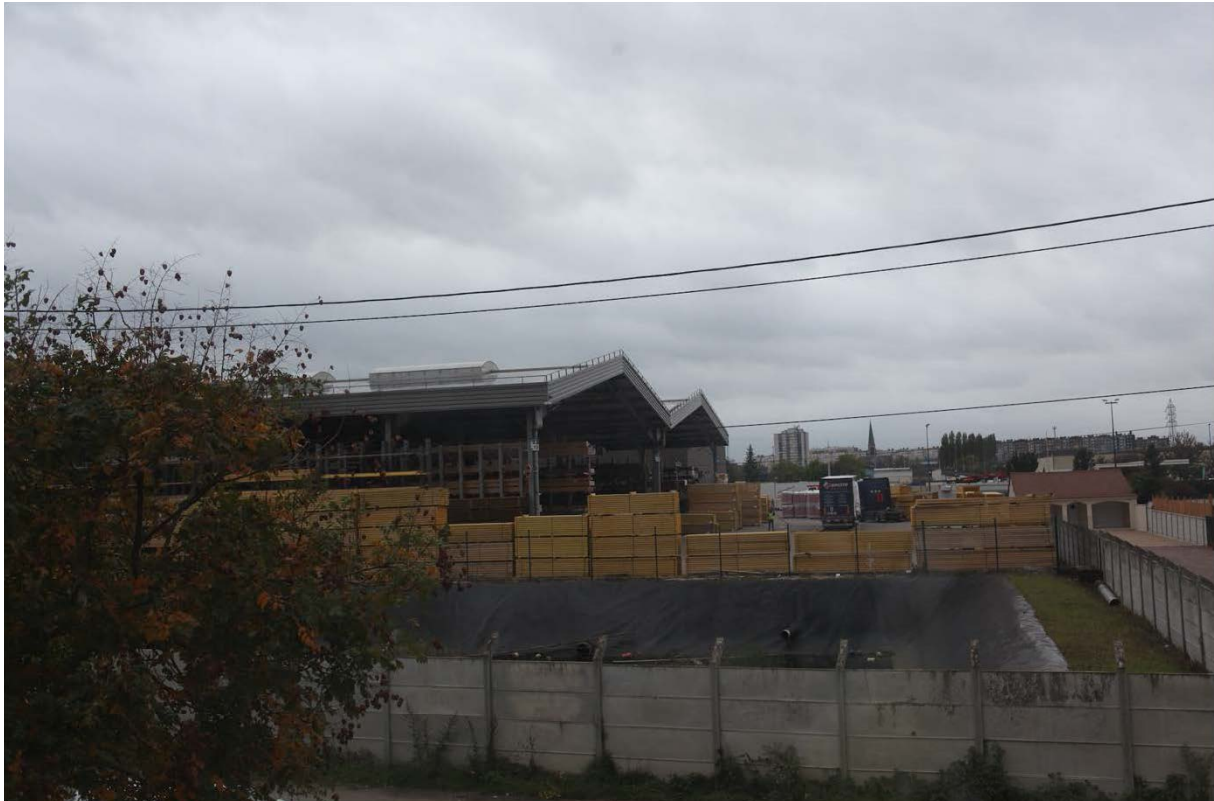
Scierie que l'on perçoit depuis le Relais accueil Gens du voyage situé sur l'aire d'accueil de Sotteville-lès-Rouen
