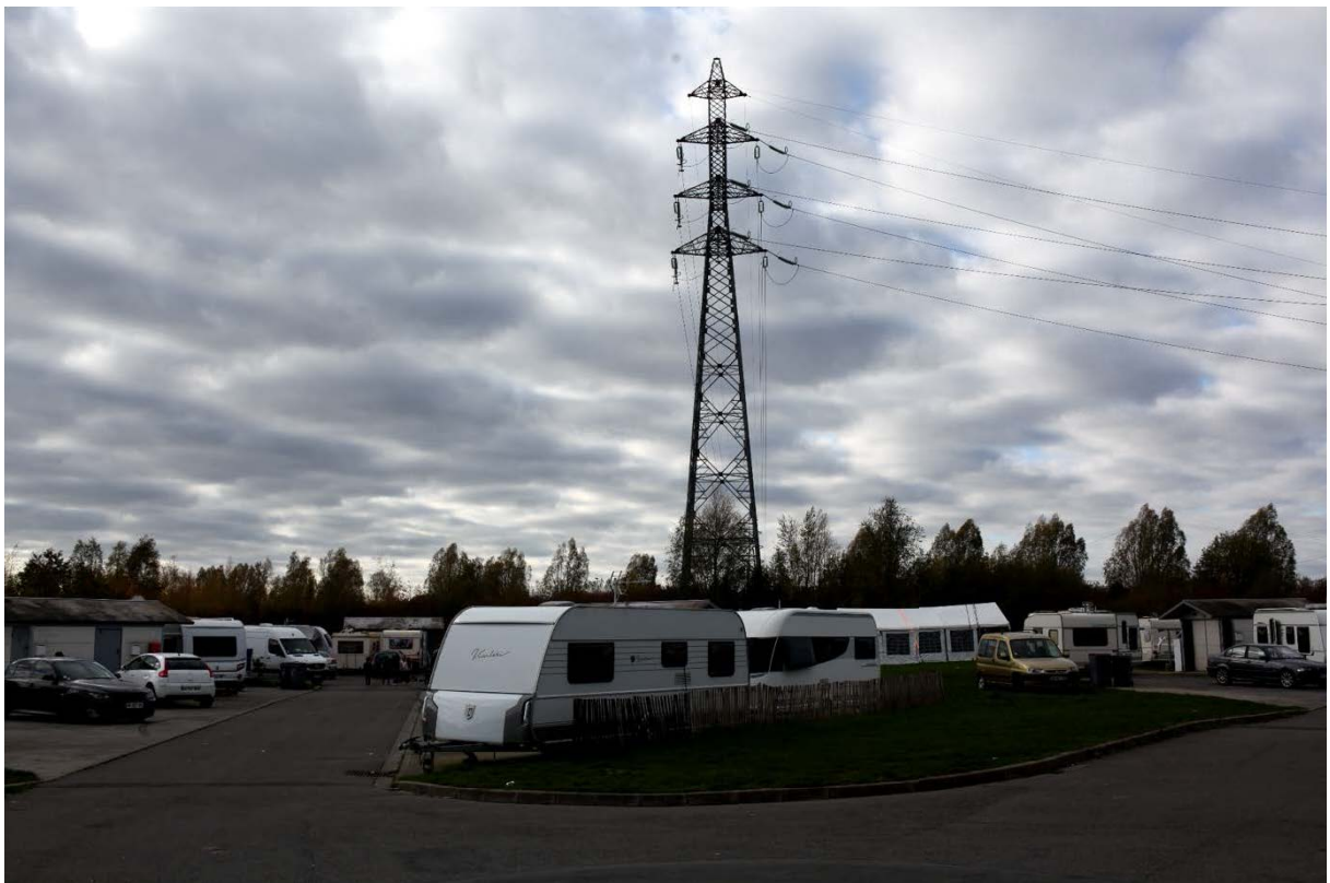
Vue sur le pylône électrique positionné en plein cœur de l'aire de Seclin
