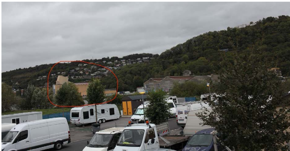
Aperçu de l'usine, depuis l'aire d'accueil de Sotteville-lès-Rouen
