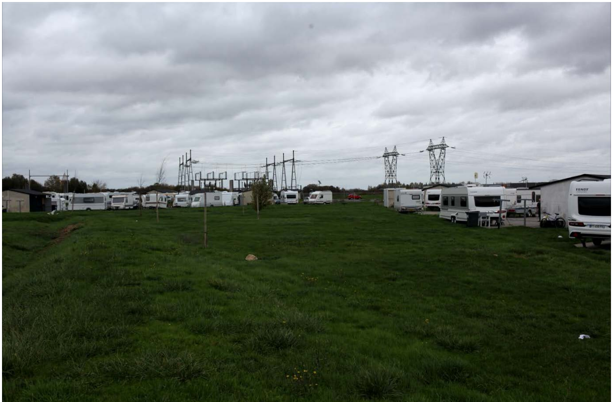
Vue sur le transformateur électrique depuis le fond de l'aire de La Chapelle-d'Armentières
