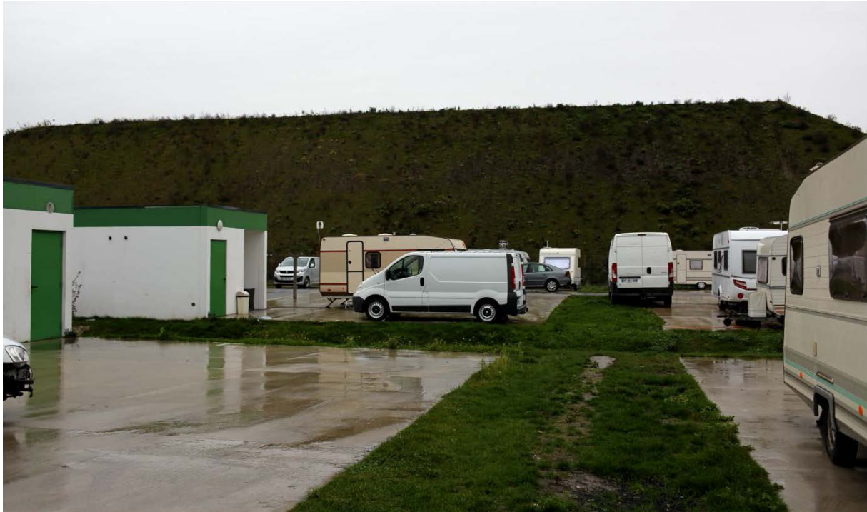
Vue sur le monticule de terre qui borde l'aire d'Onnaing
