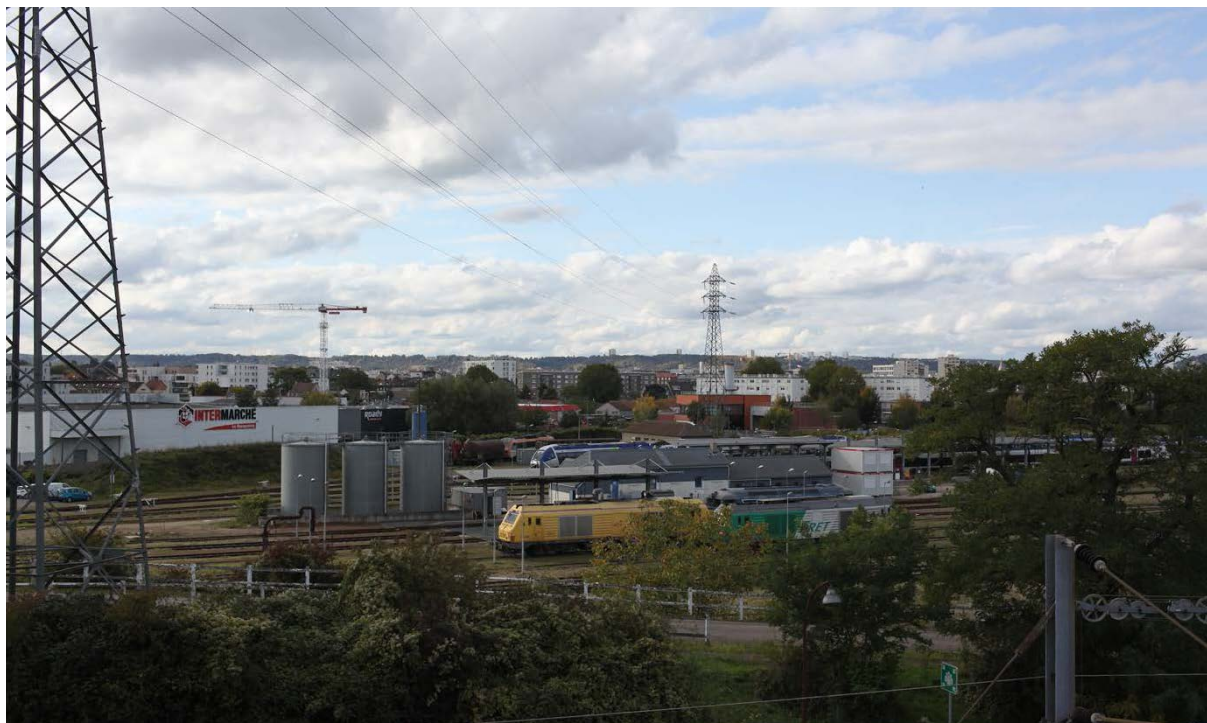
Vue sur la ligne à haute tension depuis le pont permettant de rejoindre le centre-ville de Sotteville-les-Rouen
