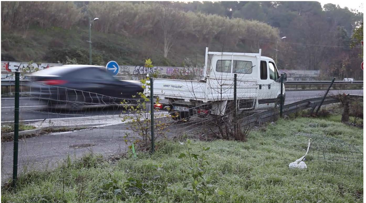
Voie d'insertion sur la 2x2 voies depuis l'aire d'accueil de Montpellier (photo datant de 2016)
