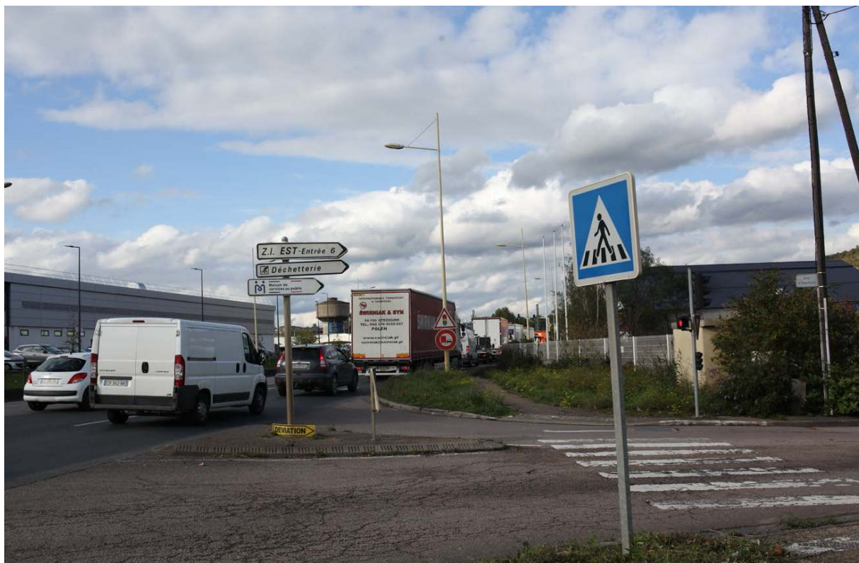
Voie d'accès à l'aire d'accueil depuis le principal axe routier reliant Sotteville-lès-Rouen et Rouen
