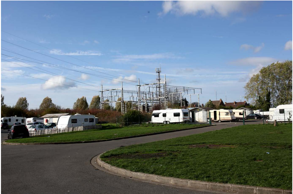
En entrant sur l'aire de Seclin, vue sur le transformateur électrique
