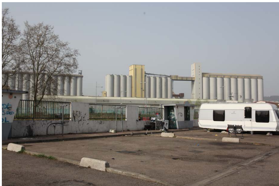
Vue, depuis l'aire d'accueil de Rouen Petit-Quevilly, sur des silos de stockage gérés par l'entreprise Sénalia
